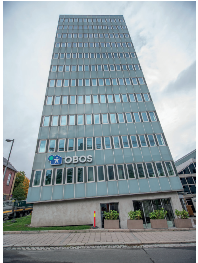
Fasadene er i utgangspunktet uendret, men bygget har fått et utvendig løft på bakkeplan.
