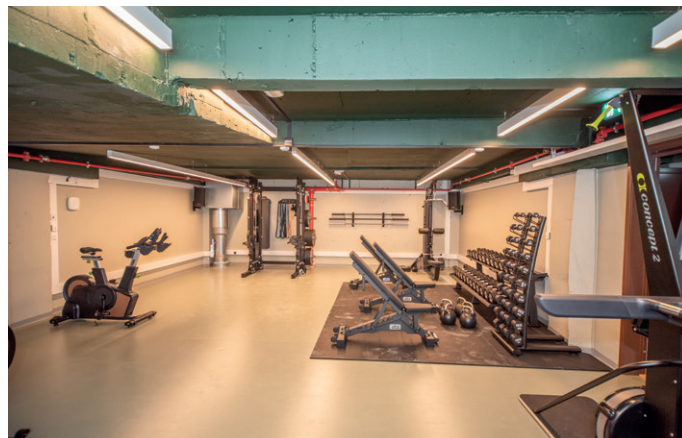
Et gammelt teknisk rom har blitt transformert til treningsrom med garderobeanlegg.
