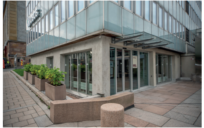
Ny belegningsstein og rehabilitert fasade utgjør de største endringene utendørs.
